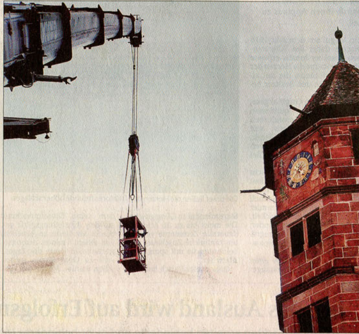
Das Kamera-Team wurde am Turm entlang vom Kran nach oben gezogen.
